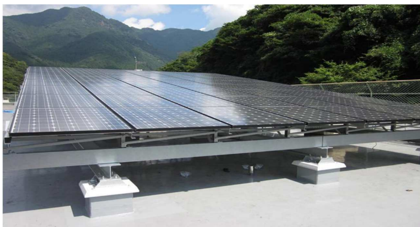
図表 6-12 設置箇所の状況
