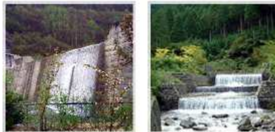
砂防ダム・治山ダム
