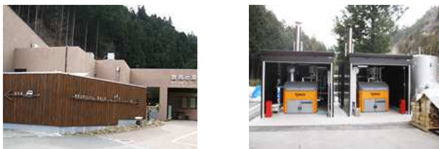
図表 6-4 設置箇所の状況
