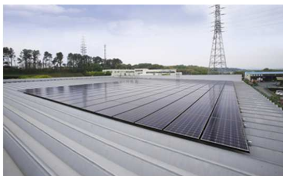
図表 7-19 設置箇所の状況（左）及び周辺状況
