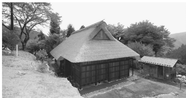
重要文化財小林家住宅
