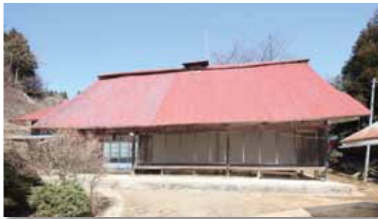
修理前外観(南より)
