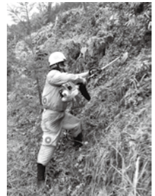
空調服を着て下草刈作業
