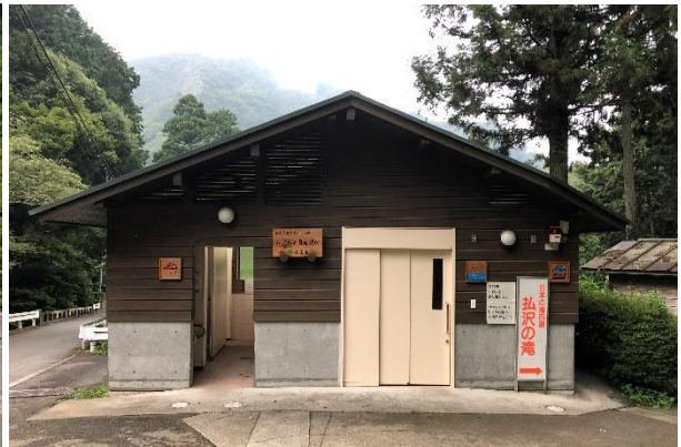
2 払沢の滝駐車場トイレ
