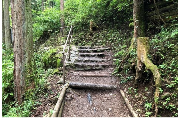
階段に手すりを設置
