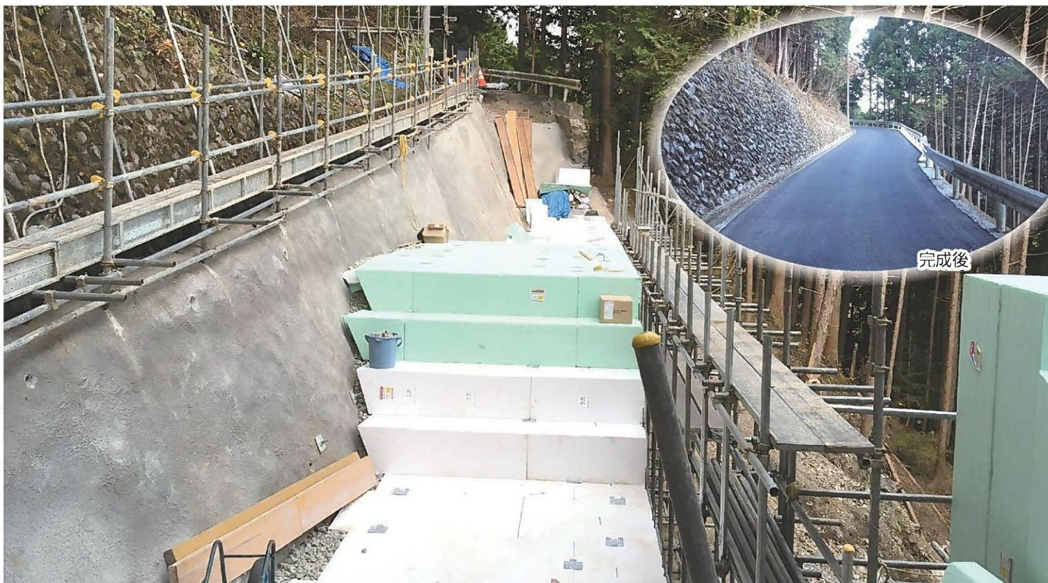
早期復旧を図るため、EPS工法(発泡スチロール土木工法)を用いた
