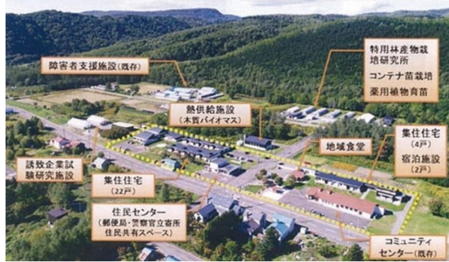
図表 資 5-9 一の橋地区バイオビレッジの概観
