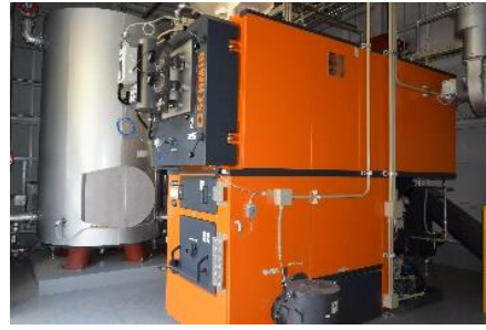
図表 6-2 数馬の湯の薪ボイラー（左）、やすらぎの里のチップボイラー（右）
