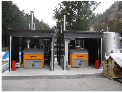
図表 6-2 数馬の湯の薪ボイラー（左）、やすらぎの里のチップボイラー（右）
