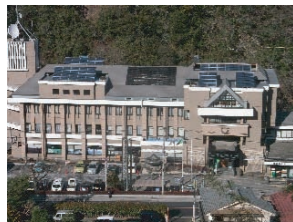
太陽光発電 役場では蓄電池も備え災害時にも利用できます
