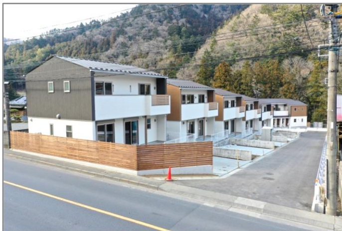
村営みどり住宅
